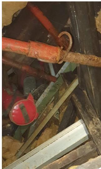
*Figure 7 : Trémie stabilisée par des étaies - Bauges (photo : P. Verdier)*
